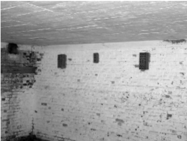
Holle bakstenen als vleermuizenschuilplaats
