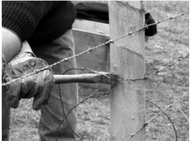
Koen Vanagtmael van Natuurpunt leert onze leden hoe ze zelf de afspanningsdraad kunnen herstellen. Hier zie je het aanspannen van de draad met eenvoudig gereedschap.
